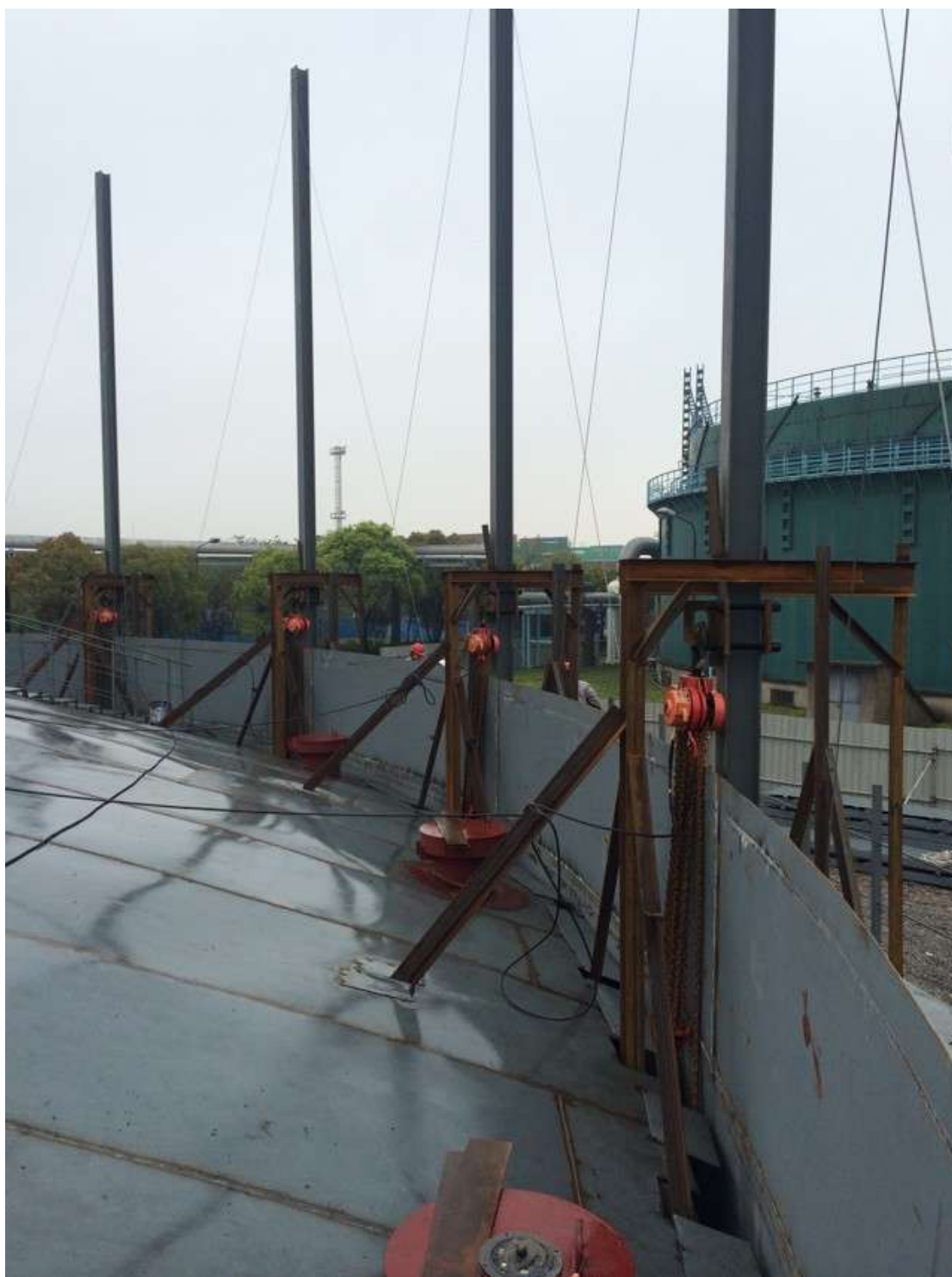
10T 环链电动葫芦施工现场
